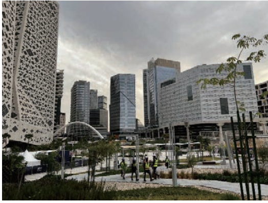
現在も工事が進む KAFD
