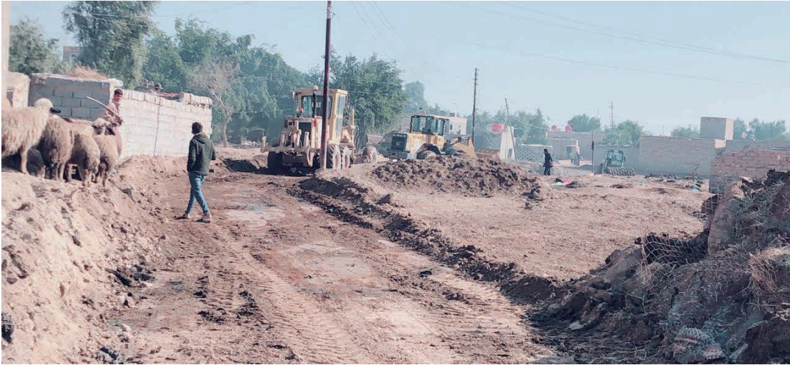
村落へのアクセス道路建設
