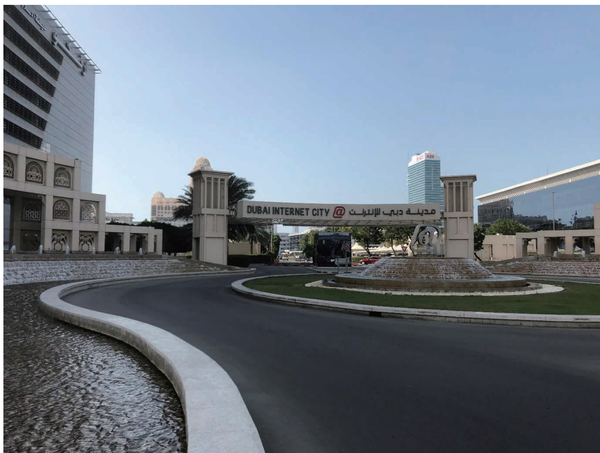
ドバイ・インターネット・シティ (DIC) の正面ゲート
