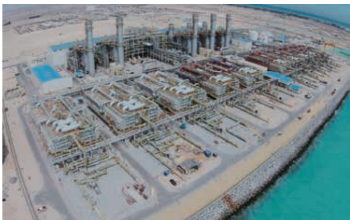
アズール・ノース発電造水プラント
