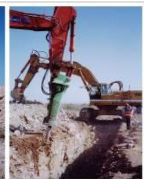
Pose tuyau "Diamètre 1000 mm" Premier front
